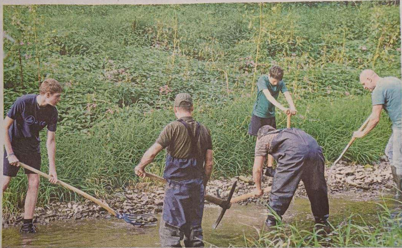
Mitglieder des Backnanger Anglervereins sind an einer Stelle zirka 100 Meter flussabwärts nach dem Käser-Wehr mit Spitzhacke, Schottergabel und Wasserlanze im Einsatz, um die Uferbefestigung aufzulockern. Foto: privat
